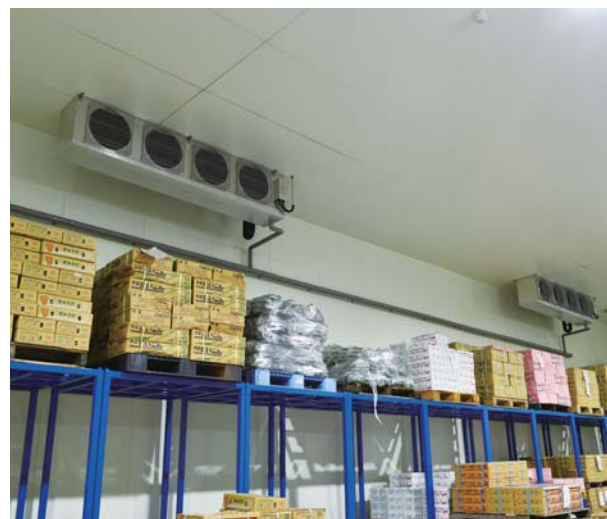
▲冷蔵倉庫内のユニットクーラ。青果を冷やすため 3.5℃に設定。
