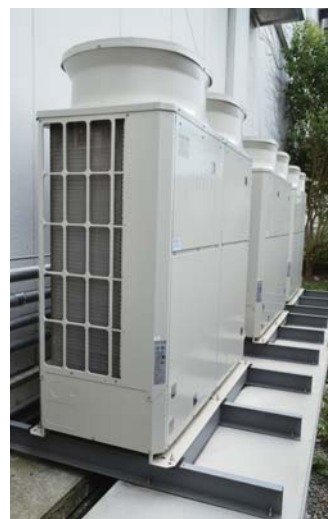
▲屋外に3台設置の R410Aコンデンシングユニット。
