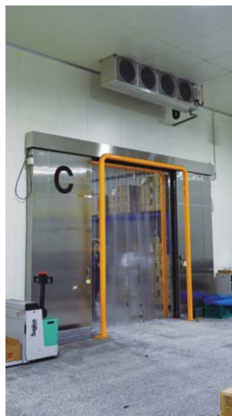
▲冷蔵倉庫内のユニットクーラ。青果を冷やすため 3.5℃に設定。
